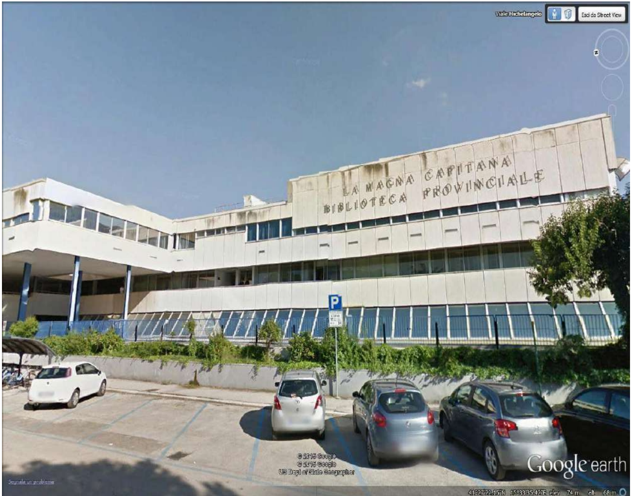
BIBLIOTECA PROVINCIALE DI FOGGIA PROVINCIAL LIBRARY OF FOGGIA "LA MAGNA CAPITANATA" ING. ROMANCIUC STEFAN ANNO COSTRUZIONE 1972
